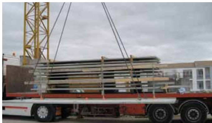
Manutention des prédalles équipées de garde-corps
