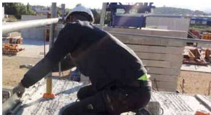
Pose des KoffraRives en sécurité
